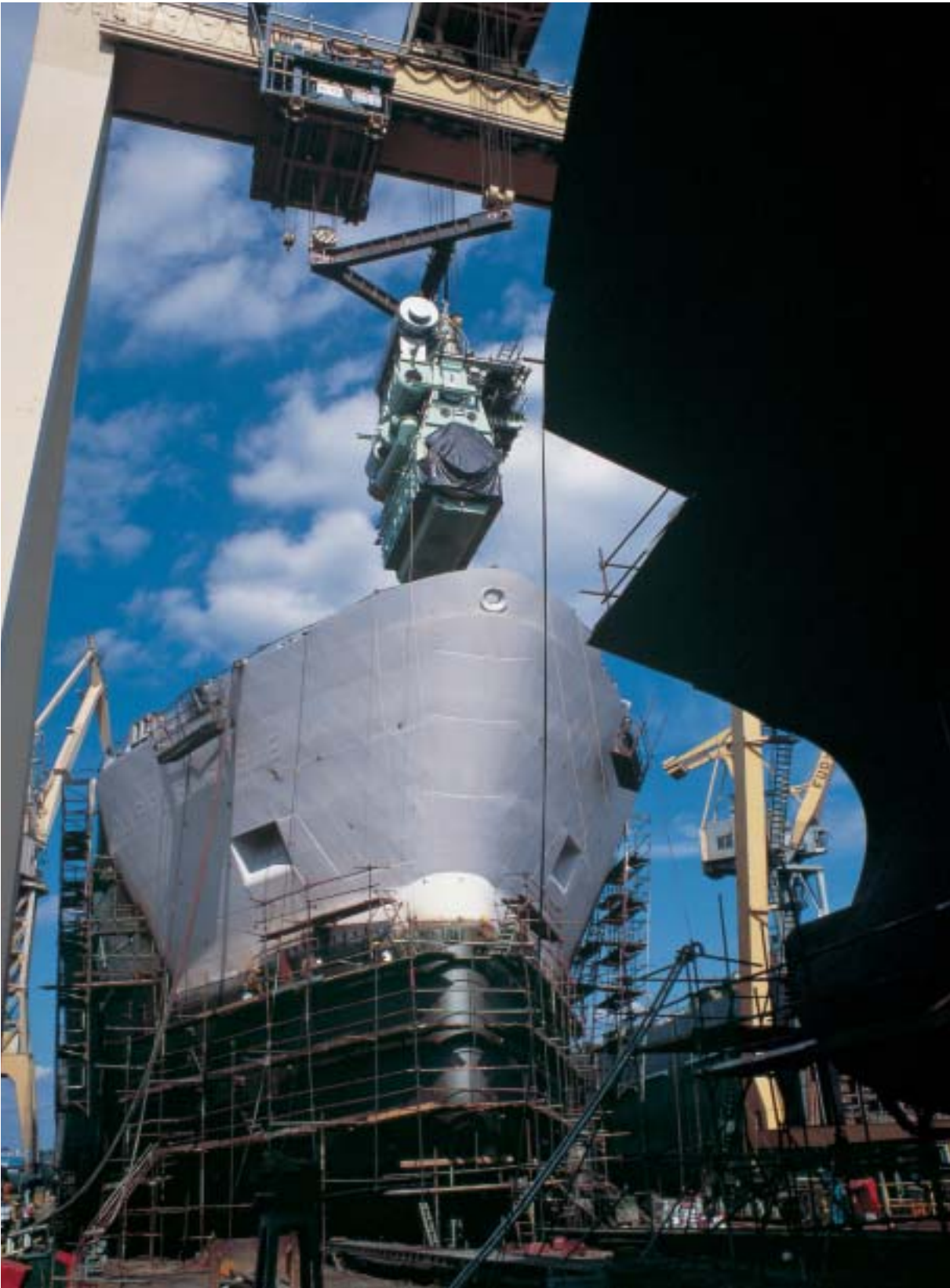
Einsetzen der Hauptmaschine in einen Neubau der Stettiner Werft.
