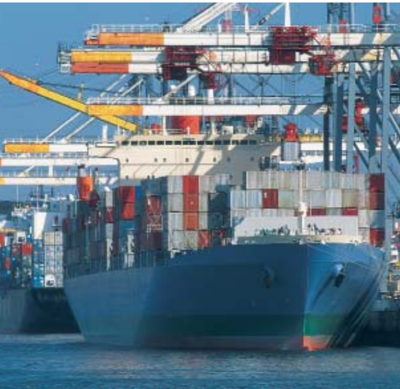
Containerbrücken auf dem Eurokai-Terminal in Hamburg.
